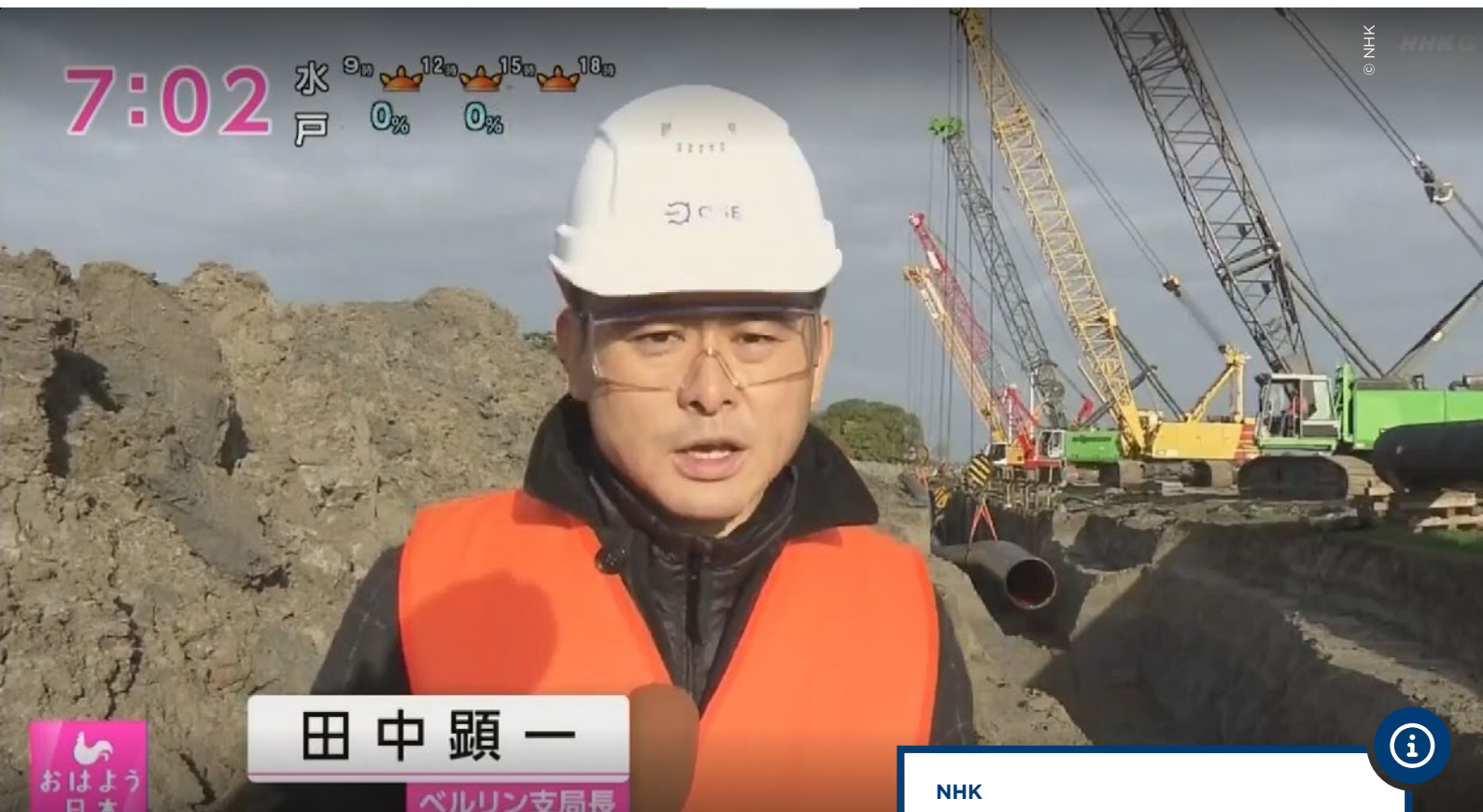
Die Reporter besuchten die WAL während der Rohrverlegung.
