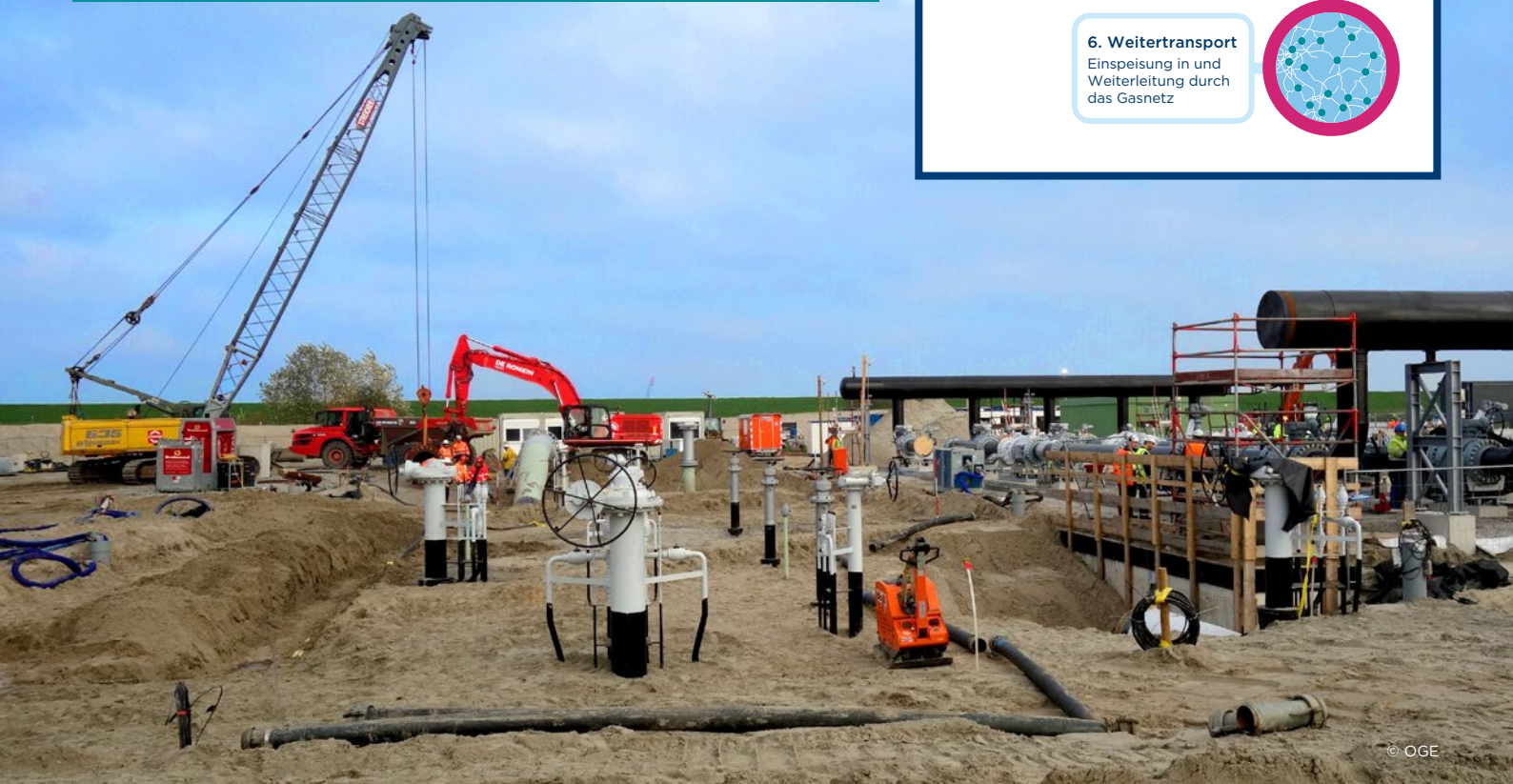
Die fast fertige GDRM-Anlage ist hier bereits größtenteils im Boden verschwunden. Sie ist zentral für den reibungslosen Betrieb der WAL.
